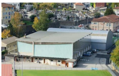
Travaux sur les équipements sportifs : 127 560 €
