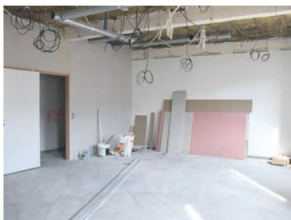
Fin des travaux du siège : 425 000 €
